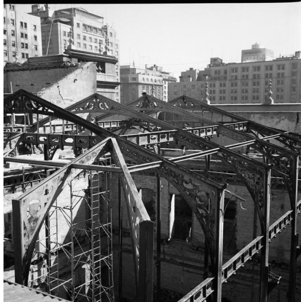
Vista aérea del Patio de Invierno 1973, actual Patio del Canelo (Registro fotográfico MOP)
