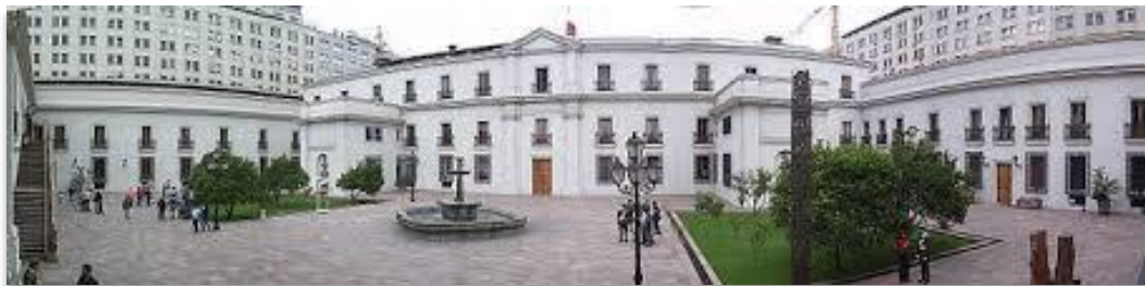
Vista panorámica del actual estado del Patio de los Naranjos.
