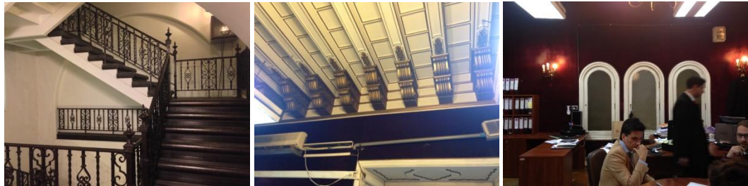
Imágenes del estado actual de los pasillos y oficinas del edificio ala sur.
