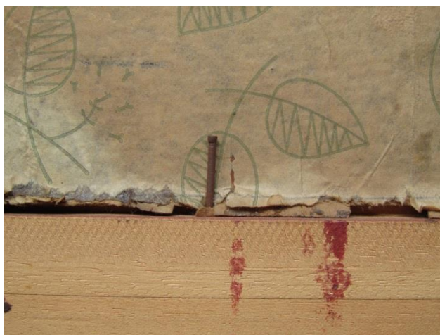
Sujeción al marco con clavos
