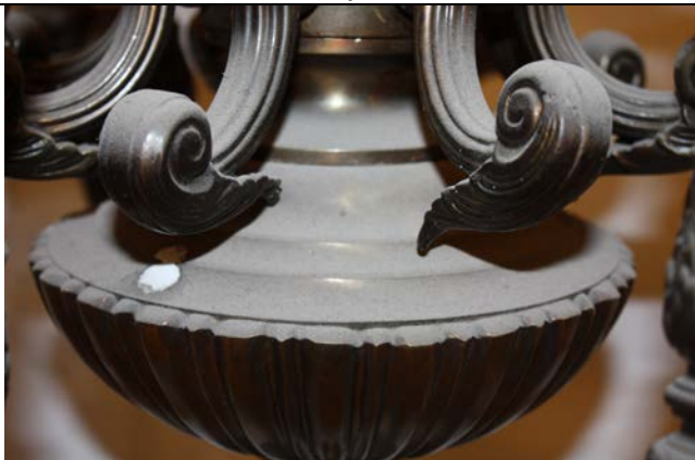
Detalle de salpicaduras de pintura y acumulación de polvo sobre eje y volutas correspondientes a los brazos.
