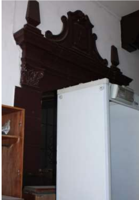
Imagen 42. Ala sur, planta baja. Zaguán lateral poniente. Detalle del portal. Agosto 2015.
