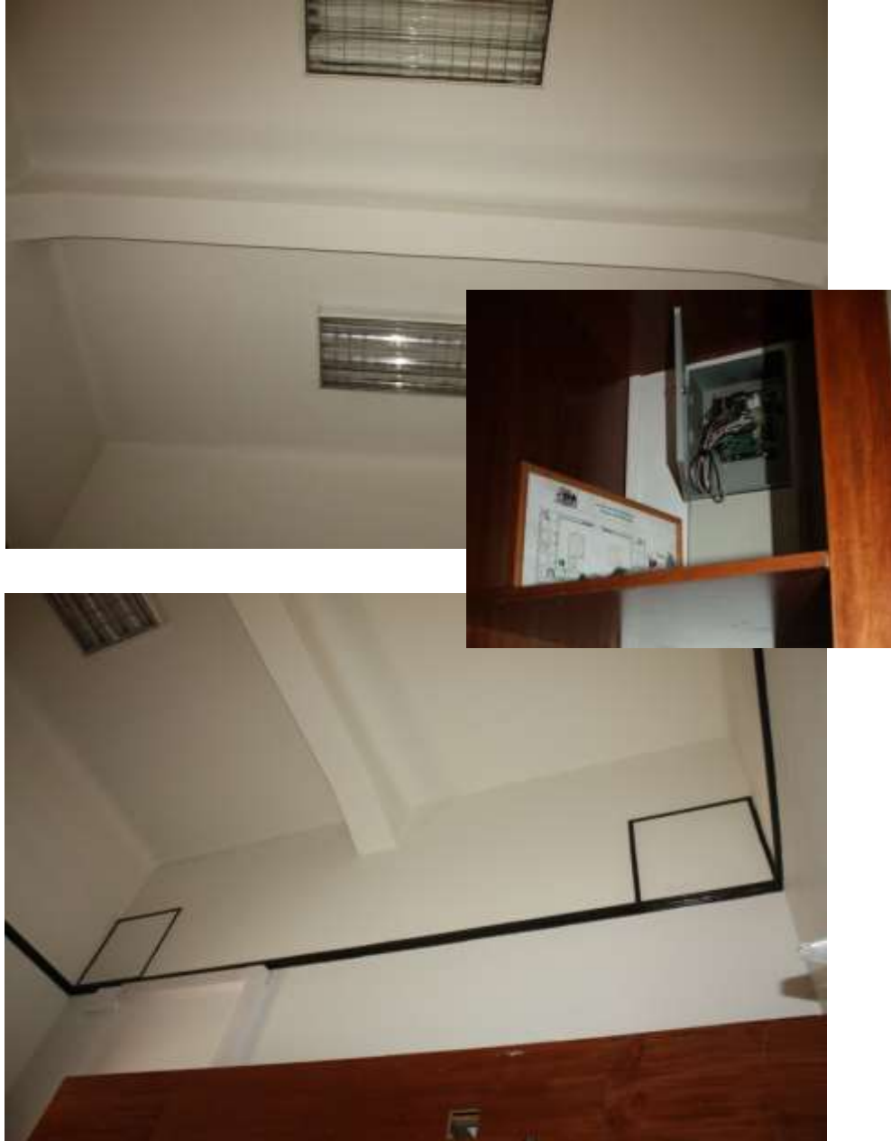
Imágenes 61 (arriba) y 62 (abajo). Oficina 229 designada con la letra B en el plano “Planta Segundo Piso Sur”. Correspondiente a la “Sala de Adscriptos” en los planos de Smith Solar y Smith Miller. Detalle del cielo. Agosto 2015.
