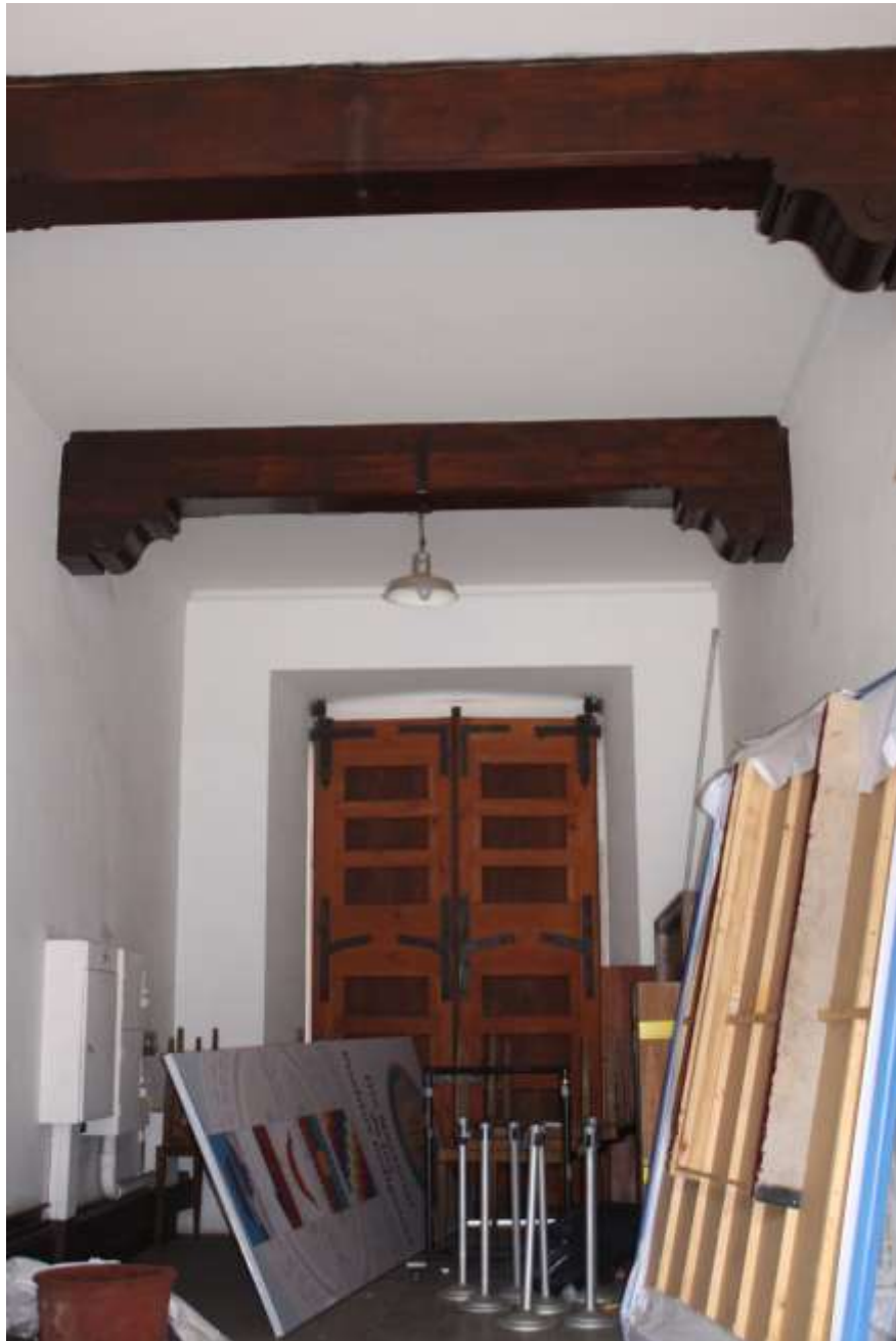
Imagen 41. Ala sur, planta baja. Zaguán lateral poniente. Agosto 2015.
