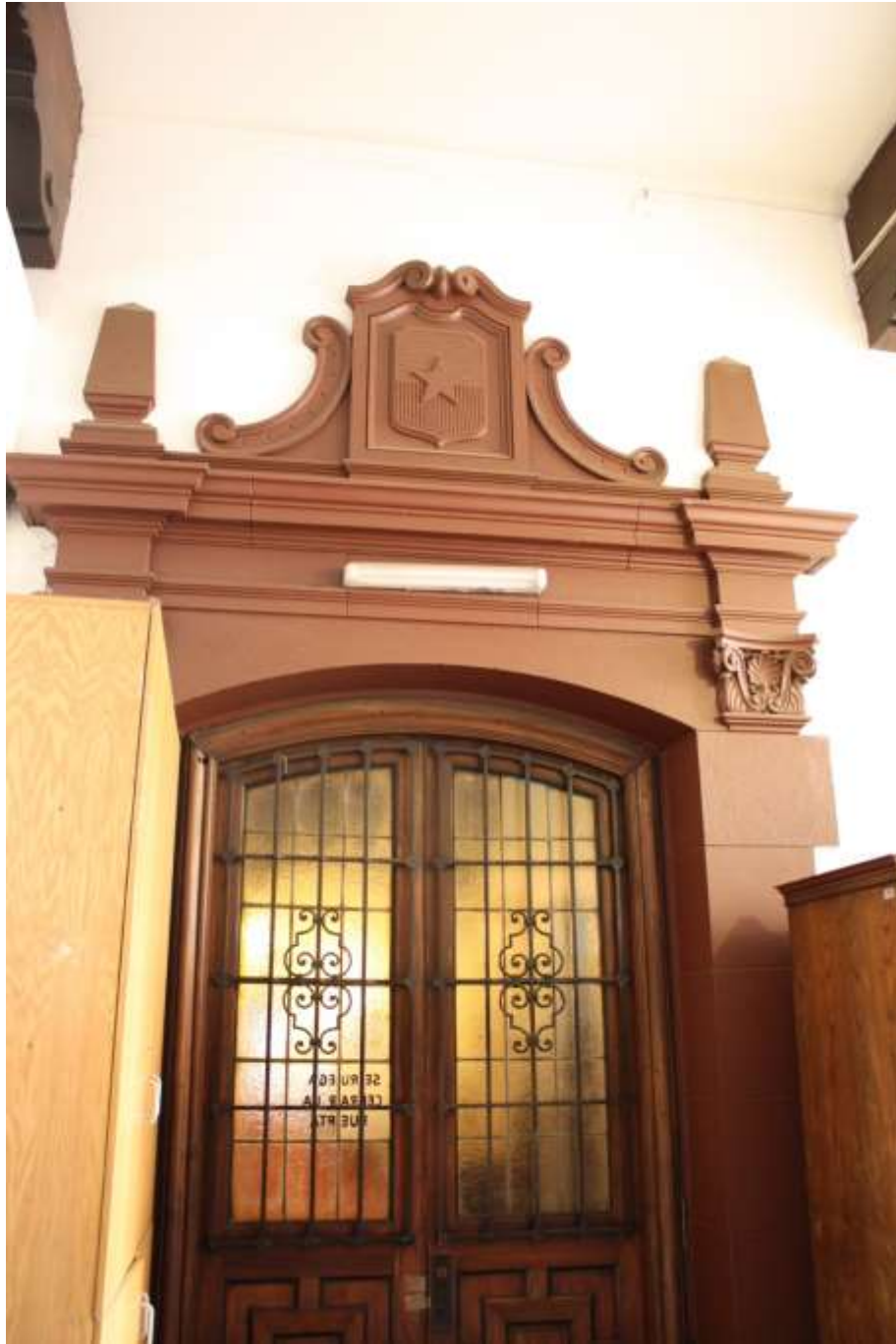
Imagen 38. Ala sur, planta baja. Zaguán lateral oriente. Detalle del portal. Agosto 2015.
