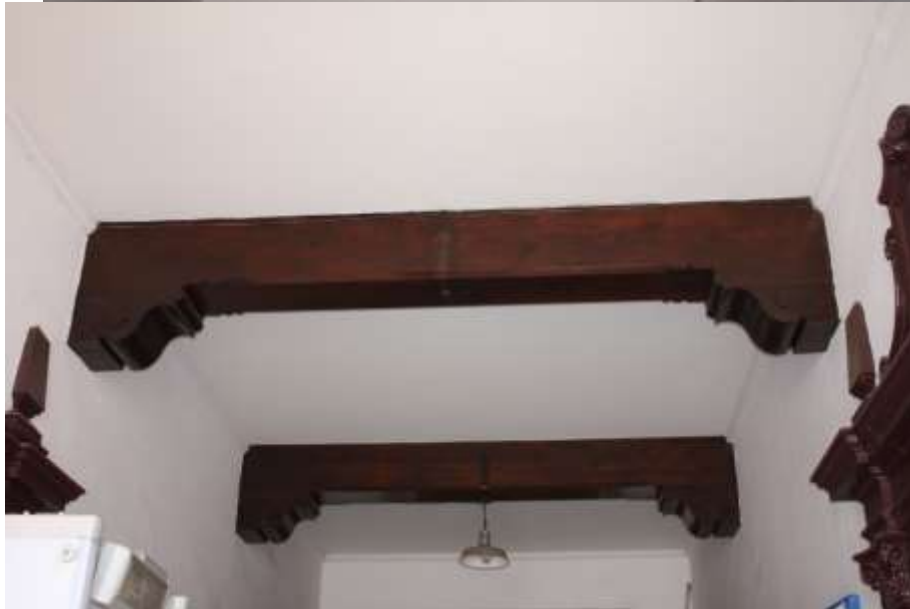
Imagen 43. Ala sur, planta baja. Zaguán lateral poniente. Detalle del cielo. Agosto 2015.
