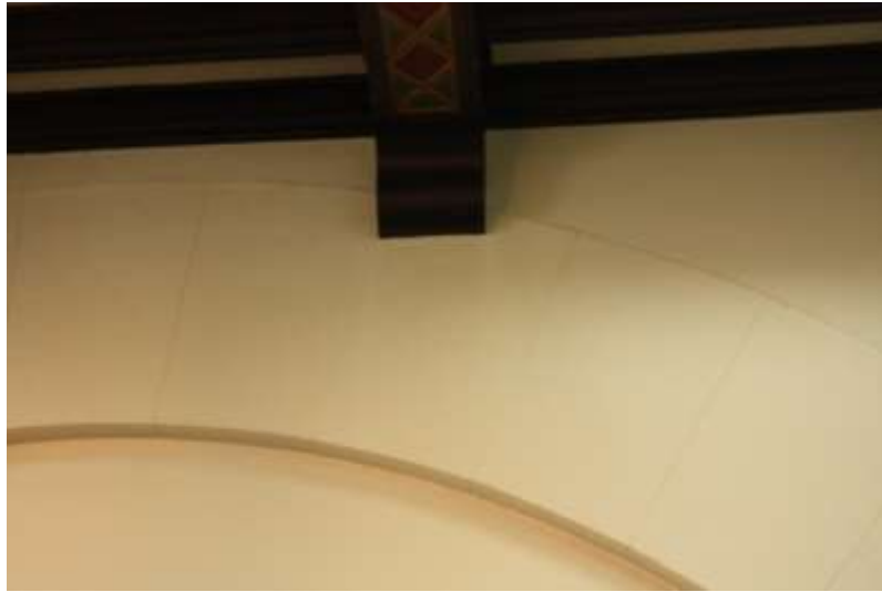
Imagen 32. Sala 100. Detalle de la intersección entre el cielo y el muro. Agosto de 2015.
