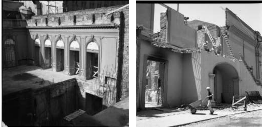
Imagen 21. Restauración del Palacio de la Moneda posterior al bombardeo de 1973. Archivo Técnico, Dirección de Arquitectura, Ministerio de Obras Públicas.
