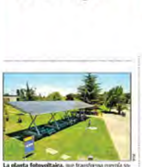
La planta fotovoltaica, que transforma energía solar en eléctrica, tiene 84 paneles que pesan 5.600 kilos.
