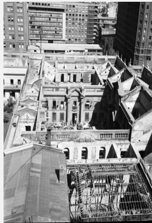
Fig. 2 Esta imagen, correspondiente al período de reconstrucción del Palacio entre los años 1974 y 1981, nos muestra en su segmento inferior la antigua estructura de la cúpula que cubría el Patio de Invierno. AFDA Archivo Fotográfico Dirección de Arquitectura. Ministerio de Obras Públicas.
