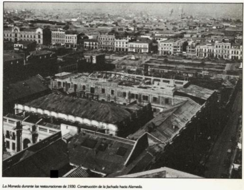
La Moneda durante la restauración de 1930, fachada sur. 27
