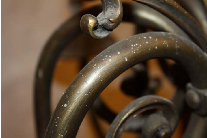
Salpicaduras de pintura y acumulación de polvo sobre uno de los brazos.
