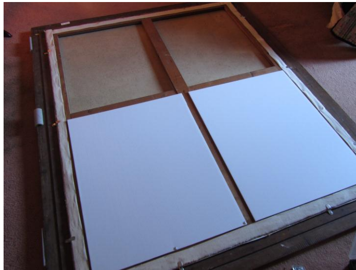
Instalación de protector de respaldo o trasera
